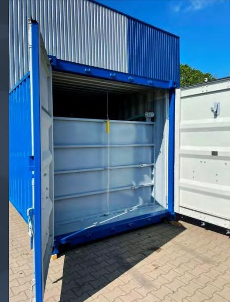
Der Container wird umgebaut zur TIW Schutzwanne für den passgerechten Tankeinbau mit 4mm S 235 Schwarzstahl Platten geschweißt und 2K Epoxidharz Beschichtung versiegelt.
